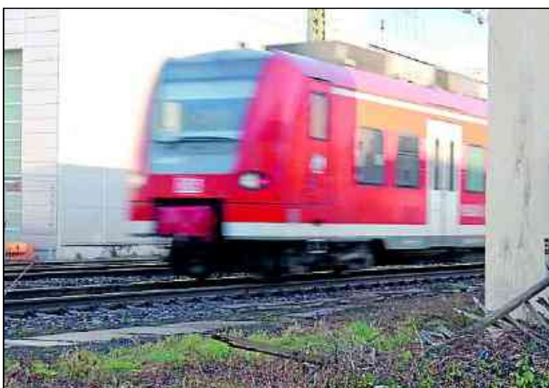
An der August-Lepper-Straße sind die Schienen frei zugänglich. Die Bahn prüft, was es damit auf sich hat. FOTO: CLAUDIA SÜLZEN
